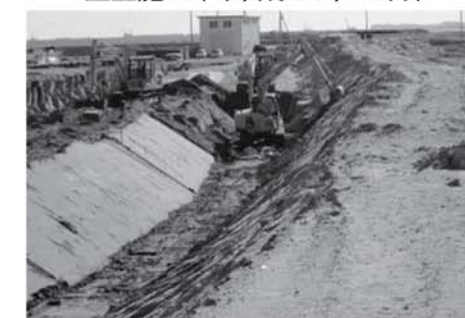
基礎部分施工中(平成25年1月)
