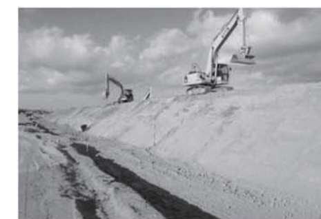
盛土施工中(平成24年12月)
