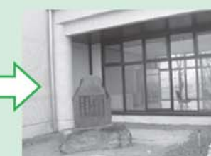
玄関周辺 復旧後
