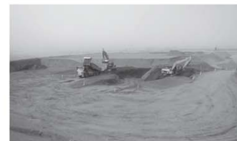
新浜地区の再生材の仮置き場
