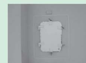
防水窓 復旧後
