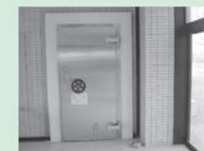
中央監視室(防水扉)復旧後
