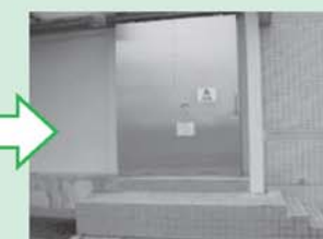
電気室扉(防水扉) 復旧後
