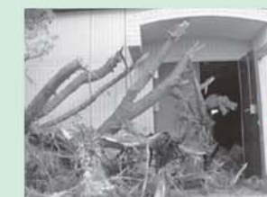
電気室扉 被災時
