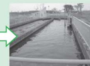
処理槽 復旧後
