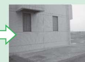
沈砂池棟 復旧後
