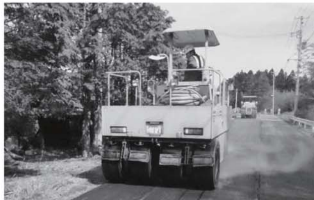
傷んだ舗装を復旧しています
