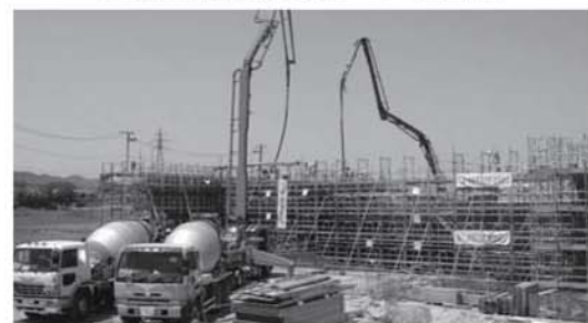
大型特殊車両がボックスカルバートを造ります
