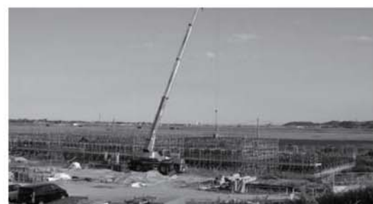
山元IC付近の大型クレーンでの工事
