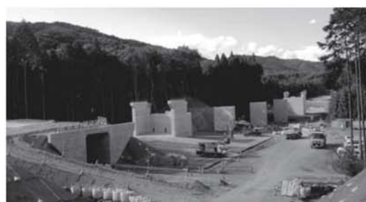
中山地区の坂元1号橋の下部工
