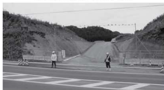
大型ダンプが出入りする箇所には誘導員を配置するなど、安全対策を徹底しています(鷲足地区の土取場入口)
