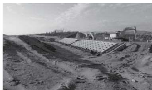
笠野：護岸ブロック設置
