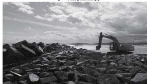
中浜：工事用道路（海側）
