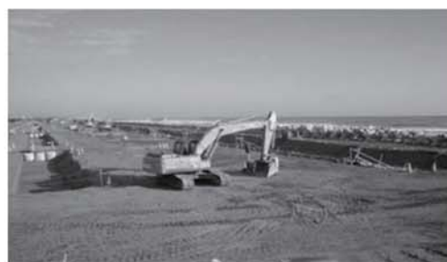
笠野：堤防盛土前
