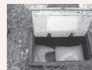
③メーター両脇の管に保温材をのせます。
