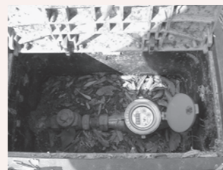
量水器ボックスのフタを開けて指針を確認
