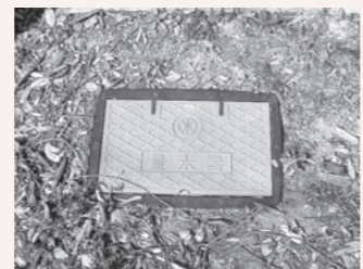
整備された量水器ボックスの周辺
