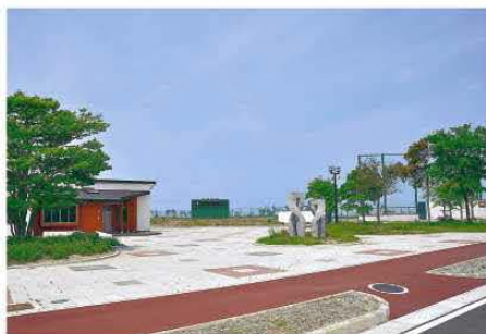
7月5日 被災した牛橋公園の復旧工事が完了し、再オープンを祝した記念式典を開催。
