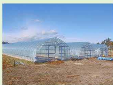
完成した3棟のリーフレタスハウス
