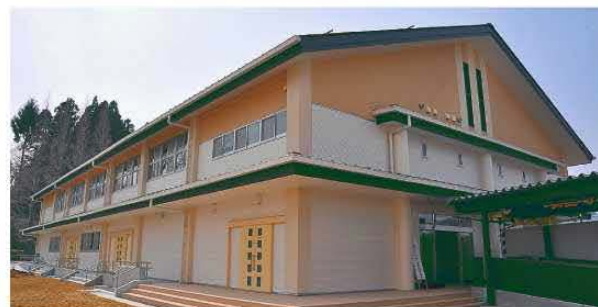
3月16日 震災で損壊し新たに建設が進められてきた坂元小学校体育館が避難所機能を兼ね備えた施設に生まれ変わり、落成。
