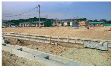
新坂元駅周辺地区新市街地内で着々と進む宅地造成工事
