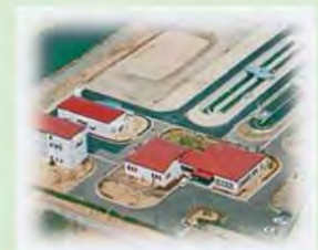
山元浄化センター(下水道施設)
