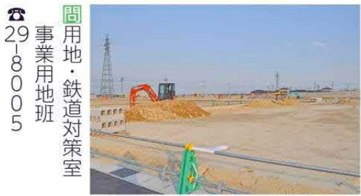
新山下駅周辺地区新市街地内で着々と進む宅地造成工事
