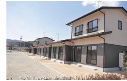
平成25年4月1日 新山下駅周辺地区災害公営住宅第1期分18戸が完成し、県内トップを切って災害公営住宅の入居がスタート。
