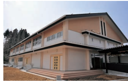
平成26年3月16日 坂元小学校体育館が避難所機能を兼ね備えた施設に生まれ変わり、落成。
