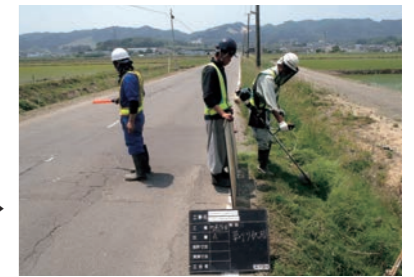
町道2号大平牛橋線の除草状況
