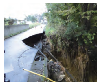
▲被害箇所は危険ですので、近づかないでください
