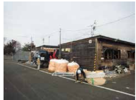
解体中の仮設住宅
