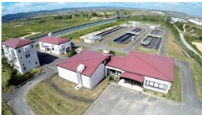
山元浄化センター（復旧後）
