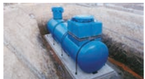
耐震性貯水槽（山下）
