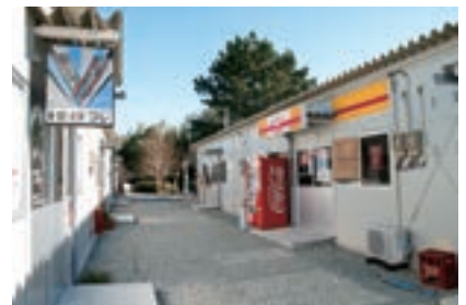
仮設店舗（町民グラウンド団地）
