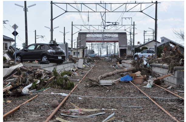
津波被災直後の旧JR山下駅
