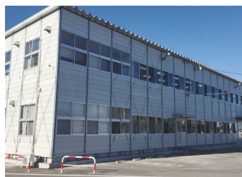
山元町役場仮庁舎
