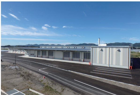
新浜地区出荷調製貯蔵施設
