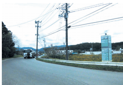
高瀬笠野線道路改良工事
