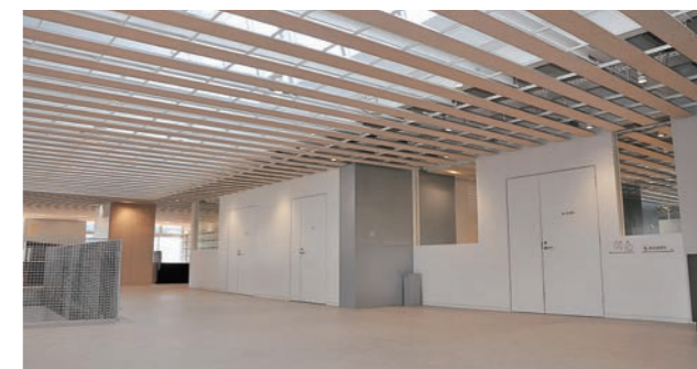
▲2階ロビー付近
