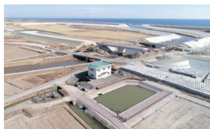
▲谷地排水機場と南側の調整池
