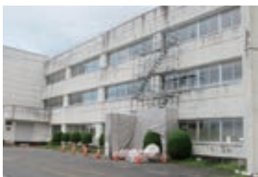
急ピッチで進むエアコン設置工事
