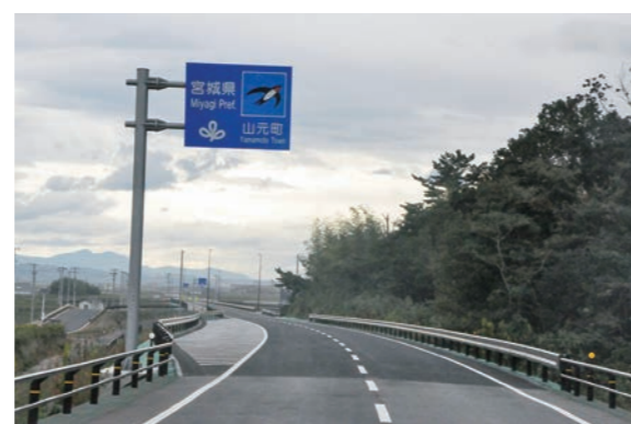
▲一部区間が開通した県道相馬亘理線(福島県側から撮影)
